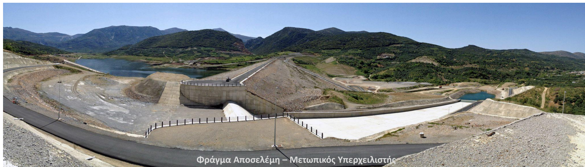
Σχήμα 6.51. Βαθμιδωτό έργο απαγωγής στην κατάντη παρειά του φράγματος βαρύτητας των Λυμπιών (Κύπρος)
