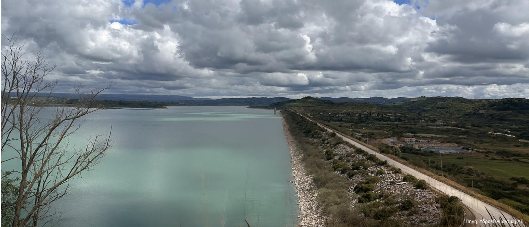
Φράγμα Πηνειού Ηλείας, 1968
